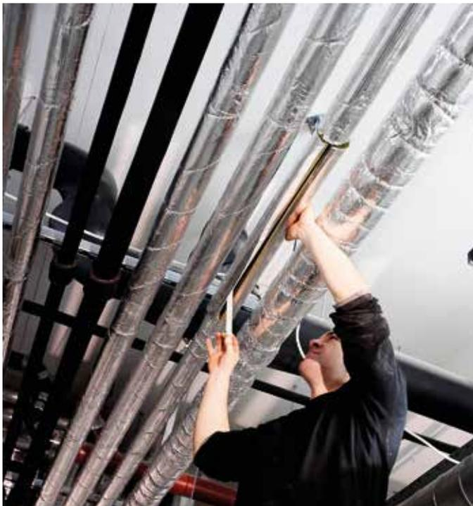
Montage der ROCKWOOL 800 an Heizungs- und Trinkwasserleitungen
