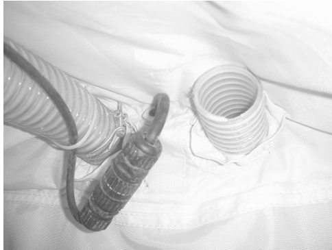
Schlauchdurchführung v on innen
