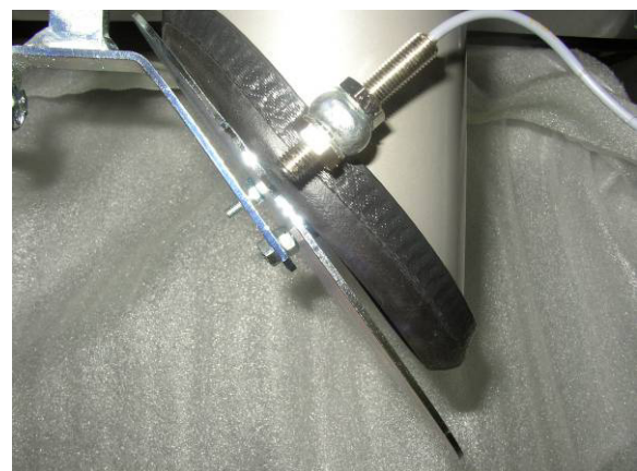
Abbildung 5: Induktiver Sensor zur Klappenüberwachung
